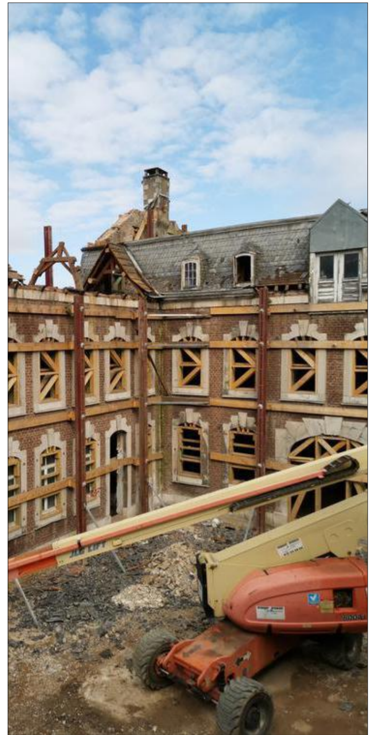
Dieses Bild entstand während der Umbauarbeiten am Eupener Marktplatz. Zum Erhalt der Bausubstanz mussten die Fassade und die Fenster gesichert werden. Foto: GrenzEcho
