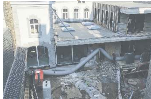
Die Umbauarbeiten am mittleren Gebäude sind bereits weit fortgeschritten. Die Fassade erstrahlt in Weiß und alle Fenster sind eingesetzt. Unten liegen noch große Schläuche im Weg, sie dienen der Entfeuchtung bzw. dem Trocken des Gebäudes. In den sechs Woh- nungen, die sich auf den Etagen 1 bis 3 befinden, gibt es aber noch viel zu tun...
