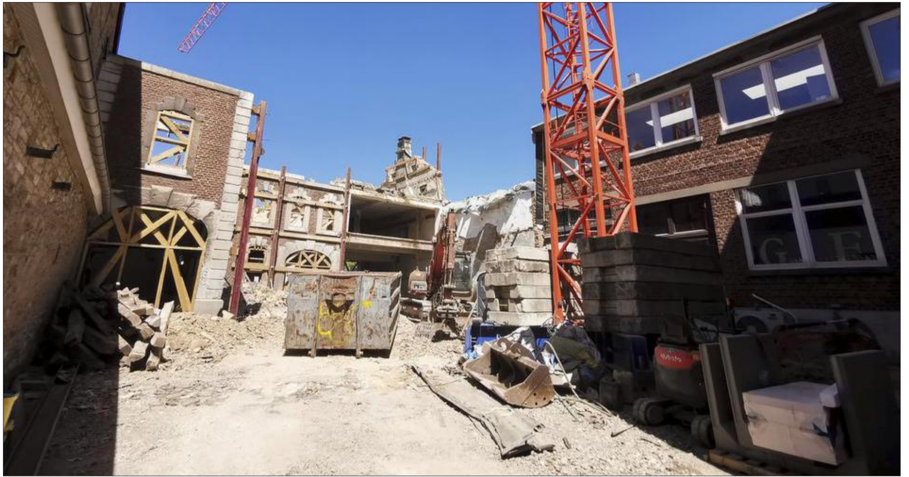
Die Bauarbeiten auf einem sehr beengten Raum erwiesen sich als sehr aufwendig.
