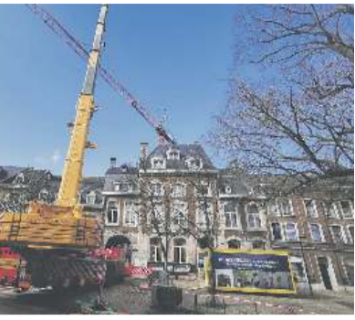
... schließlich über das vordere ... bis auf den Fuß des Krans im ... gehoben zu werden. Nicht ... zu sehen ist das Beton-Funda- ... für das Aufstellen des Krans, ... Hof gegossen wurde.
