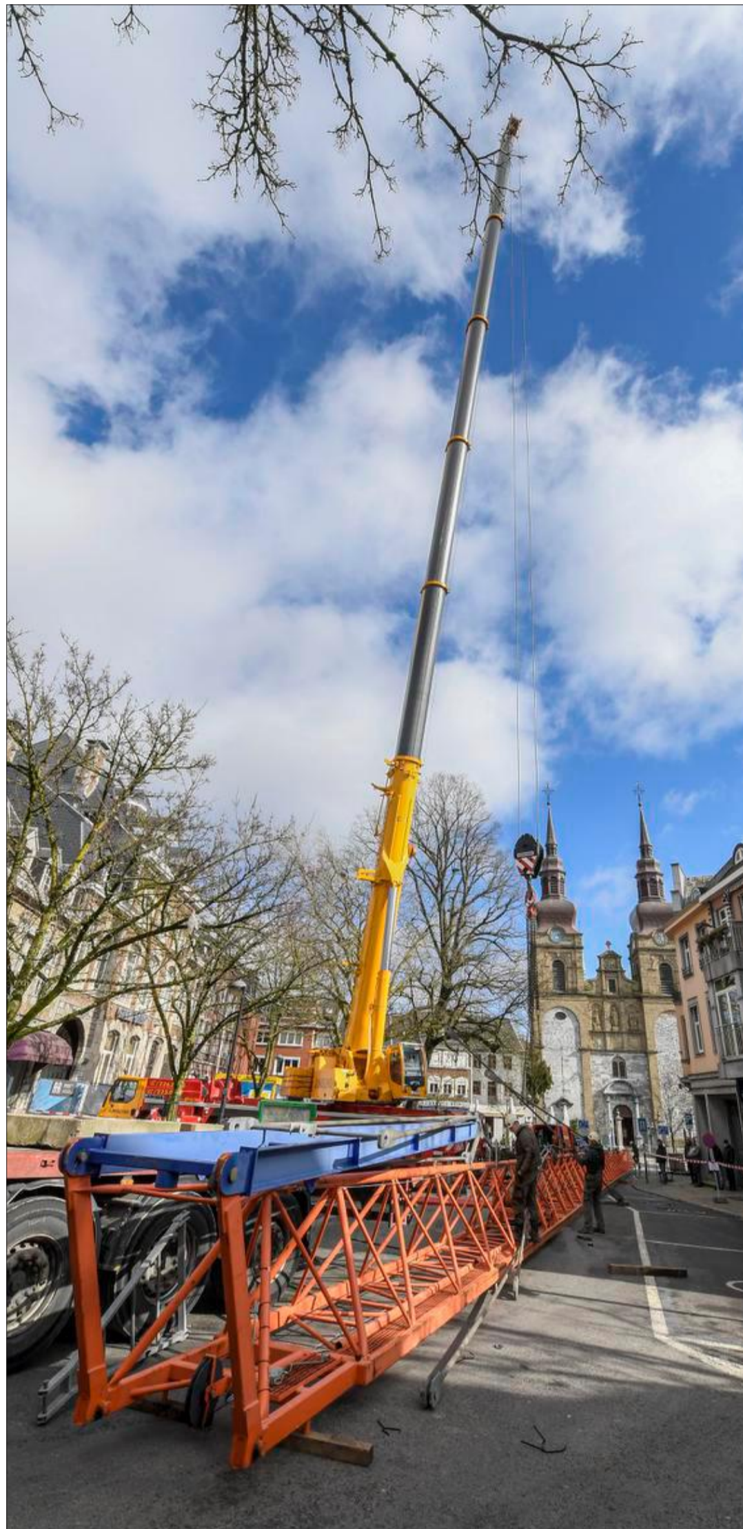
Die Neu- und Umbauarbeiten bedeuteten für alle Beteiligten eine ganz besondere Herausforderung. Foto: David Hagemann
