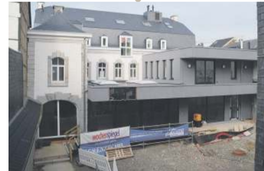
Die Wohnungen sind fertig und es konnten Mieter gesucht werden. Auf dem Foto sieht man auch den pro- visorischen Eingangsbereich links und den Platzhalter für das GE-Media-Logo.
